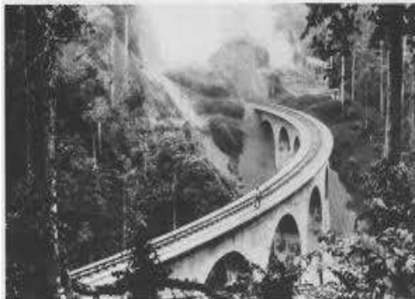
Photo n°1 : Viaduc sur le Congo-Océan dans le Mayombe
