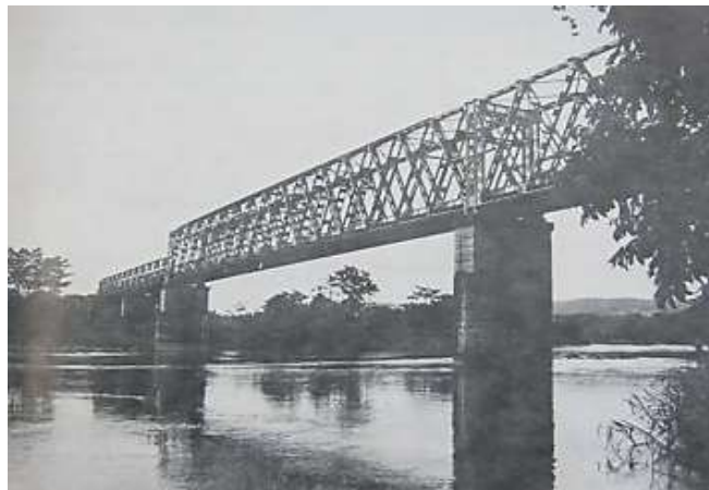
Photo n°3 : Pont-rail sur la rivière Louessé-Sud
