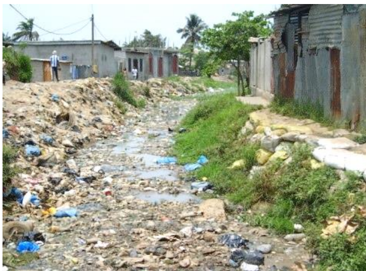
Photo 2 : Problèmes d'assainissement à Pointe-Noire. Prise de vue S. F. L. Bakanahonda, 2021
