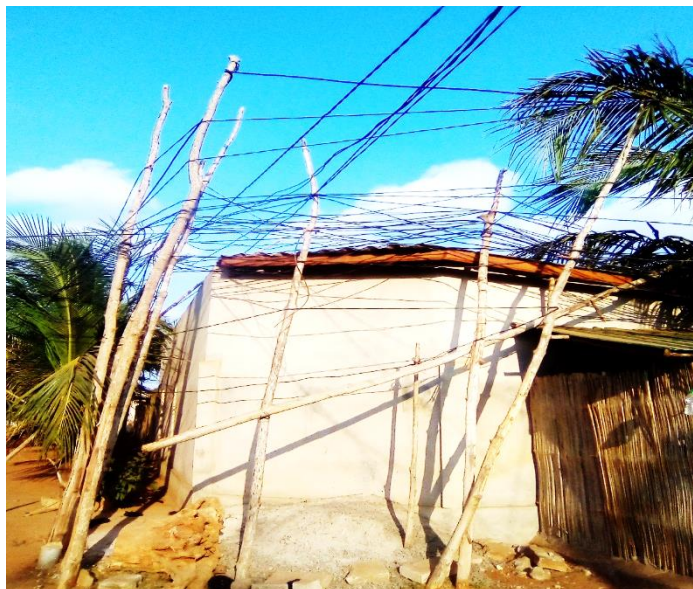
Photo 2B : Entrelacement des câbles électriques autour d'une habitation à Akato.
