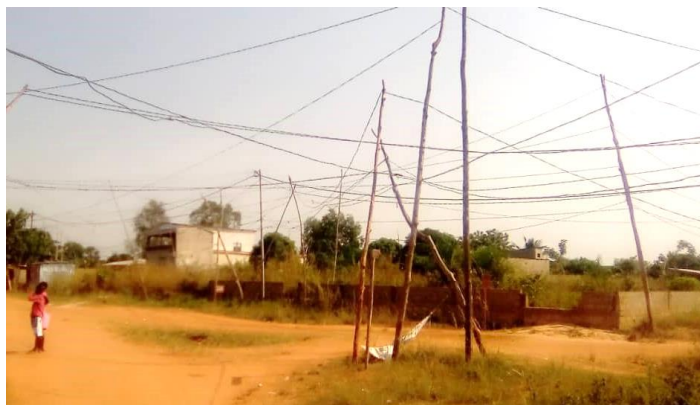
Photo 2A : Cables suspendus en forme de toile d'araignée à Klémé-Djigbé. Cliché Afeli, 2019
