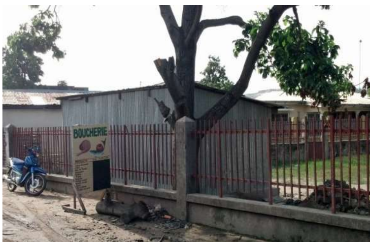
Photo 3 : Clôture métallique posée sur un muret. Cliché Nkoubango Nzoussi, 2017
