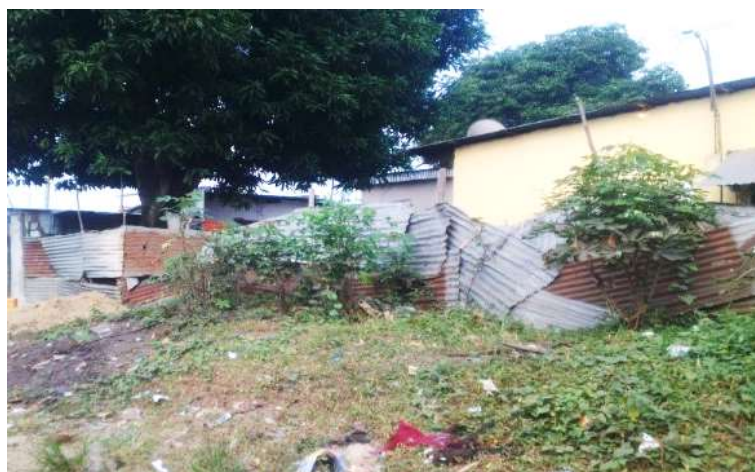
Photo 1 : Clôture sommaire en tôles de récupération. Cliché Nkoubango Nzoussi, 2017
