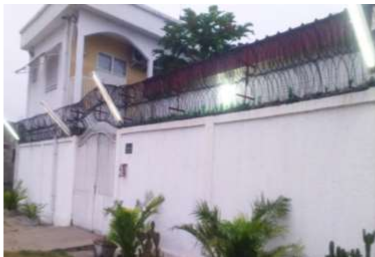
Photo 5 : Haut mur de clôture surmonté de 2 rangées de fil barbelé. Cliché Nkoubango Nzoussi, 2017
