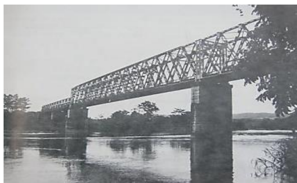
Photographie n°1 : Pont-rail sur la rivière Louessé-Sud
